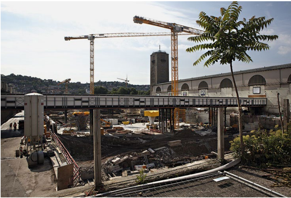
Abb. 25.3 Projekt Stuttgart 21 – Umbau des Stuttgarter Hauptbahnhofs: Das Projekt wurde erstmals 1994 der Öffentlichkeit vorgestellt, die Bauarbeiten begannen Anfang 2010. Die geplante Inbetriebnahme wurde seither von Dezember 2019 in mehreren Schritten auf 2025 verschoben. Die veranschlagten Baukosten lagen 1995 bei etwa 2,5 Mrd. Euro und haben sich inzwischen mehr als verdreifacht (Stand: Juni 2018; Bildquelle: Juergen Berger/ Picture Alliance).
