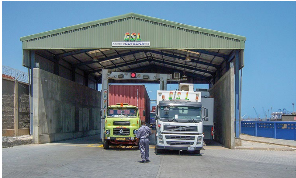
Abb. 25.5 Lkw-Scanner als Teil der Sicherheitskontrollen im Hafen von Tema (Ghana; Foto: Julian Stenmanns).
