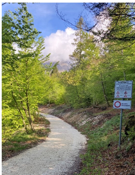
Fig. 1 – Viabilità forestale e silvo-pastorale con diversa percorribilità e con diversi criteri tecnici costruttivi. Le strade con buona percorribilità (sopra e sotto a sinistra) permettono il passaggio di gran parte dei mezzi, e.g. forwarder e trattore con rimorchio forestale. Le strade a scarsa percorribilità limitano il transito a poche categorie di mezzi, e.g. trattore con rimorchio monoasse (sotto al centro e a destra). Il fondo stradale può essere migliorato con massicciata di materiale reperito in loco (sopra e sotto al centro) o proveniente da cave (sotto a sinistra). Le piste forestali (sotto a destra) presentano fondo naturale. La larghezza della carreggiata, il raggio di curvatura delle curve/tornanti e la pendenza sono i principali fattori che condizionano la percorribilità (fonte: scrivente).
