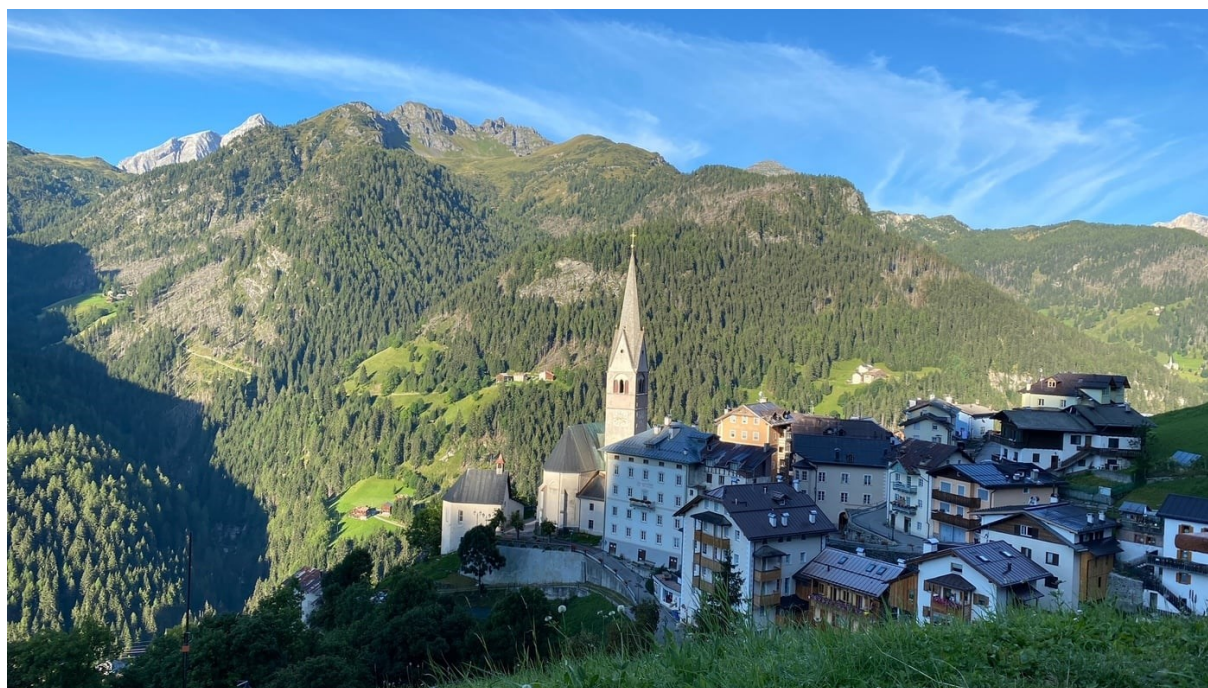
Fig. 20 – L'Agordino è caratterizzato da elevate escursioni altimetriche che si materializzano in pendenze quasi sempre elevate (sopra). I ripidi pendii boscati sono frequenti nella maggior parte delle valli (sotto: Pieve di Livinallongo del Col di Lana, BL; fonte: Arabba Fodom Turismo). Nell'immagine di Pieve si possono osservare anche le diverse matrici geologiche: calcari (Marmolada a sinistra), dolomie (Piz Boè a destra) e rocce magmatiche (catena del Padon in primo piano al centro).
